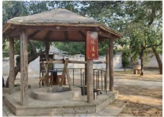
图 3-16 地道出入口（水井）
